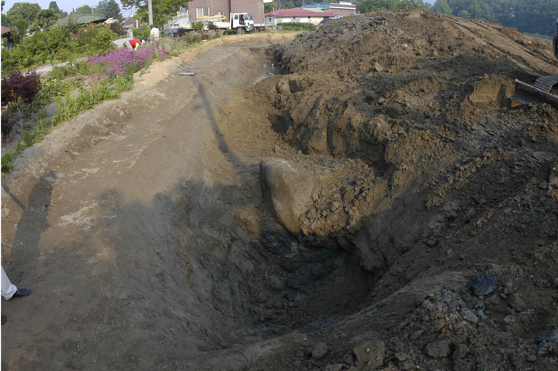
【寫眞 14】 제2트렌치 굴토 및 벽면 정리 완료후 전경[서쪽에서]
